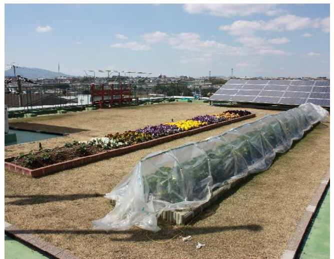
【屋上状況写真】
